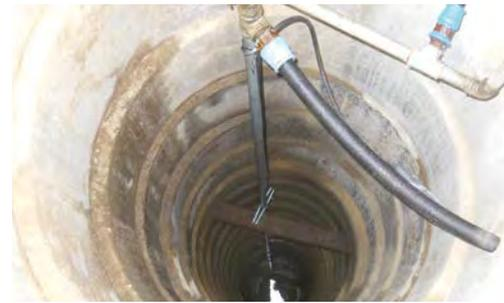
Mangelhafter Schachtbrunnen durch undichte Schachtringe
