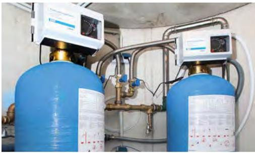
Beispiel einer Wasserenthärtungsanlage (Ionentausch-Verfahren)
